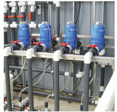
40 GPM Install (Zwart Systems)
